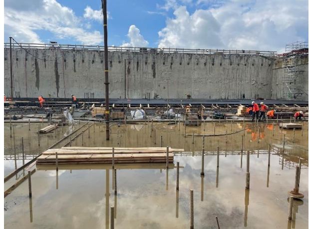
Figuur 4.4.3 Vlechten van de wapening.
