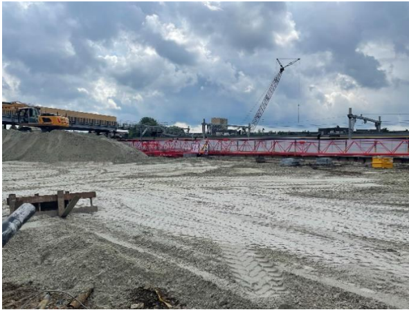
Figuur 4.3.2 Neerleggen van de nieuwe grond.
