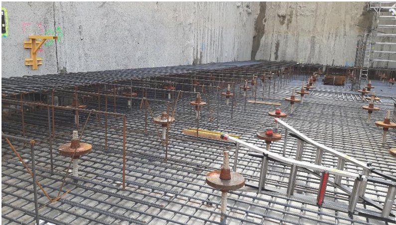
Figuur 4.4.4 Wapeningsdikte van de vloer.
