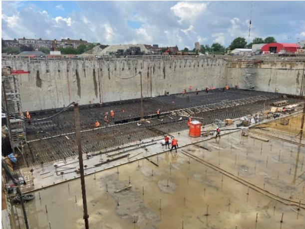
Figuur 4.4.2 Bouwput fase 3.
